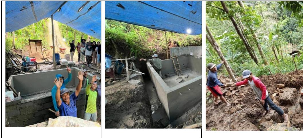
Gambar 3. Pembangunan Sarana Air Bersih
