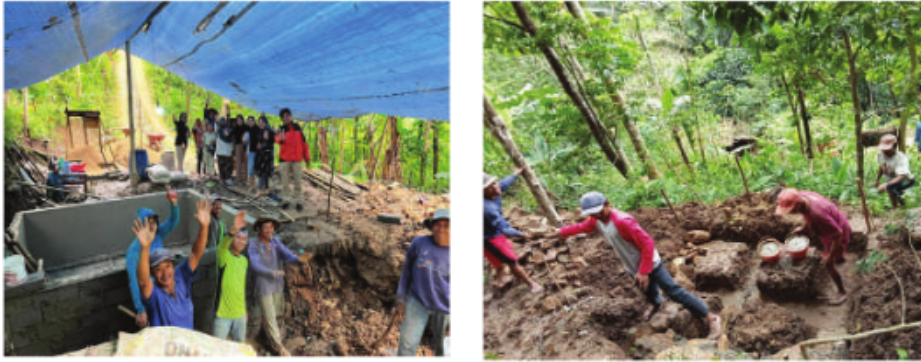
Gambar 3. Pembangunan Sarana Air Bersih
