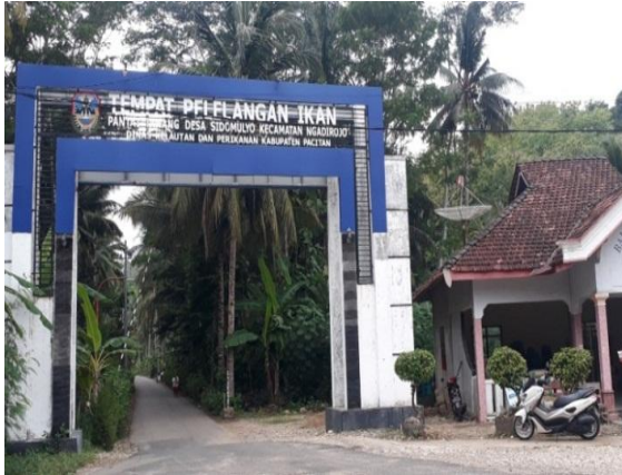
Gambar 5. Tempat Pelelangan Ikan di Kabupaten Pacitan Sumber: Dokumentasi Penulis
